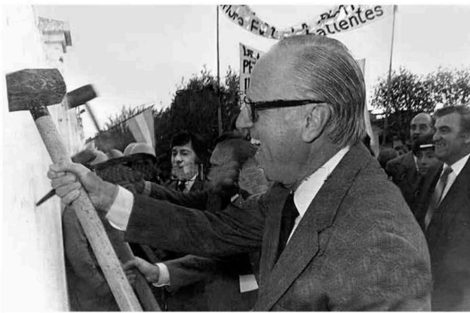
Derribamiento de muro perimetral de Regimiento 7
